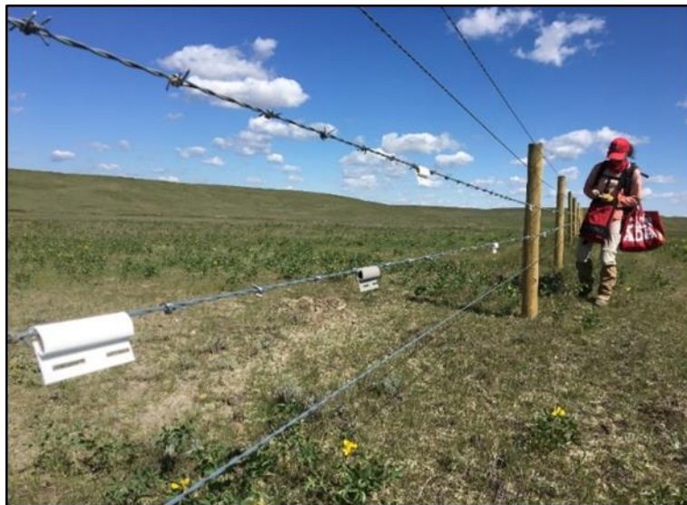
Figure 2. Un bénévole installe des parements de vinyle d'une longueur de 3 pouces (7,6 cm) le long des deux fils barbelés supérieurs d'une clôture dans l'habitat essentiel du Tétrás des armoises dans le parc national des Prairies, au cours de l'été 2018. Mention de source : L. Gardiner et Parcs Canada
